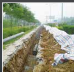
江西省 天然氣管網 一期工程
