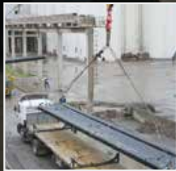
Saipem 阿爾及利亞 430KM 管線工程
