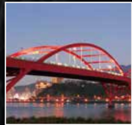
關渡大橋 管線工程
