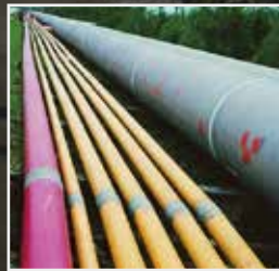
中油沙崙 油庫工程
