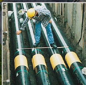
台塑六輕環台管線工程
