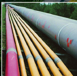
中油沙崙油庫工程
