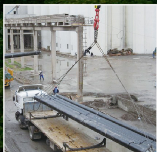
Saipem阿爾及利亞 430KM 管線工程
