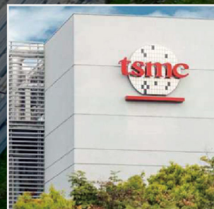
台積電各廠管線工程
